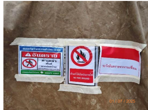
(ข) การติดตั้งป้ายเตือนแสดงเขตพื้นที่ทำการเชื่อมท่อ
