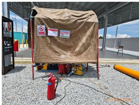
(ข) การติดตั้งป้ายเตือนแสดงเขตพื้นที่ทำการเชื่อมท่อ
