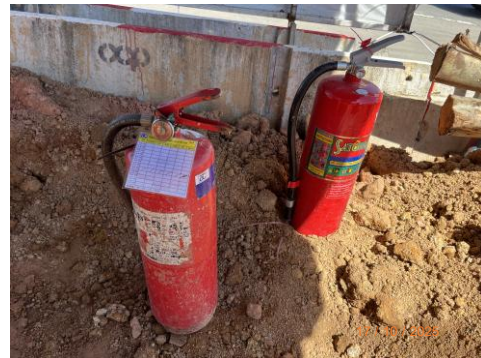
รูปที่ 2-50 เครื่องดับเพลิงผงเคมีแห้ง (Dry Chemical Fire Extinguisher) จำนวน 2 ชุด สำนองไว้ในพื้นที่ปฏิบัติงาน ตลอดระยะเวลาในการดำเนินงานต่อเชื่อม
