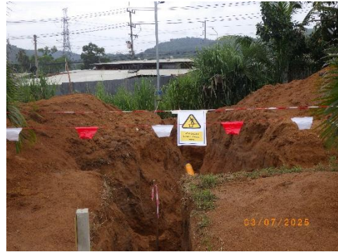
รูปที่ 2-3 การขุดเปิดหน้าดินสำหรับวางท่อเป็นช่วง
