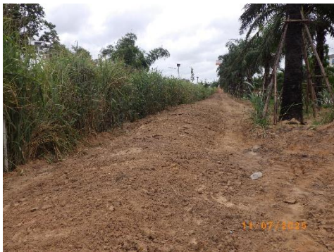
รูปที่ 2-3 การขุดเปิดหน้าดินสำหรับวางท่อเป็นช่วง
