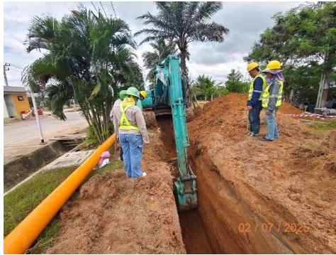
รูปที่ 2-3 การขุดเปิดหน้าดินสำหรับวางท่อเป็นช่วง
