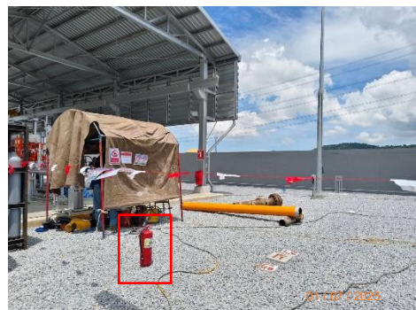
(ก) การปฏิบัติงานเชื่อมต่อฯ และการจัดเตรียมถังดับเพลิงบริเวณที่มีการเชื่อมต่อของโครงการ
