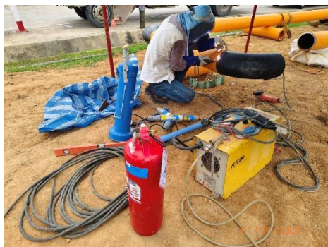
(ก) การปฏิบัติงานเชื่อมต่อฯ และการจัดเตรียมถังดับเพลิงบริเวณที่มีการเชื่อมต่อของโครงการ
