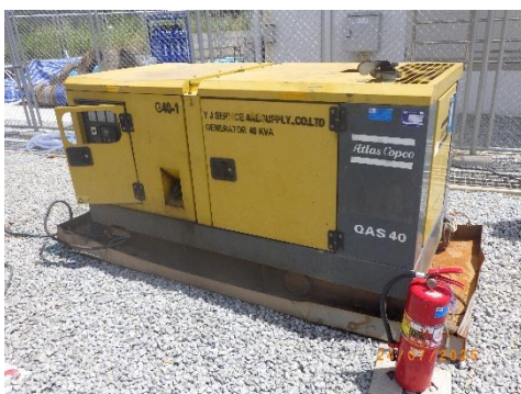
รูปที่ 2-19 ภาชนะรองรับน้ำมันและสารเคมี
