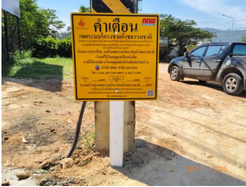
รูปที่ 2-44 ป้ายเตือนแสดงตำแหน่งแนววางท่อส่งก๊าซธรรมชาติ และเบอร์โทรศัพท์ในการแจ้งเหตุฉุกเฉิน
