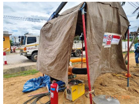
(ข) การติดตั้งป้ายเตือนแสดงเขตพื้นที่ทำการเชื่อมท่อ
